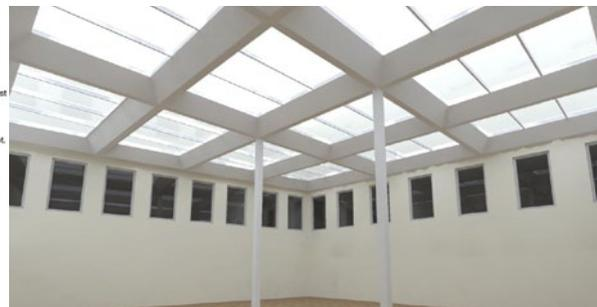
Mehrgenerationenhaus Haldensleben: durch einfache Tageslichtsimulationen können die Größe der Fensteröffnungen und die Konstruktion des Atriumdaches optimiert werden.
